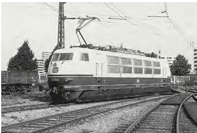
Die 103 238 erhielt 1975 versuchsweise Schallschürzen (I. Bauart).
