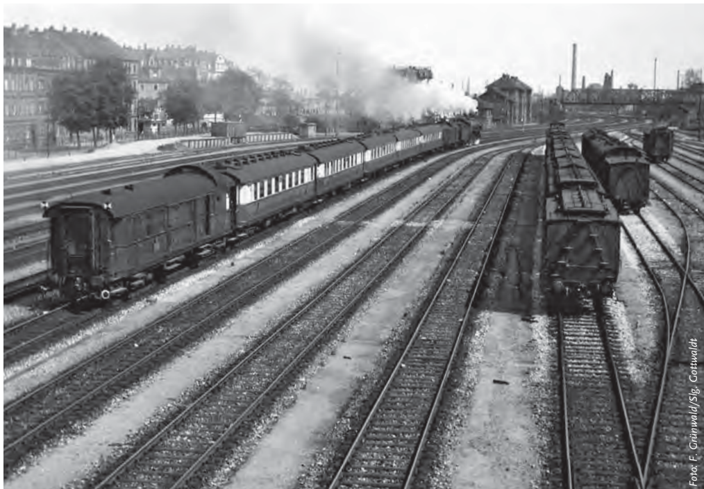
Eine badische IV h mit FFD 102 nach Basel verlässt 1929 Mannheim: am Zugschluss einer der drei für den Rheingold beschafften Gepäckwagen.
